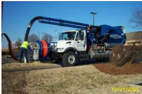
Metro tiene que limpiar las grasas de las tuberías Sanitarias para evitar desbordamientos
